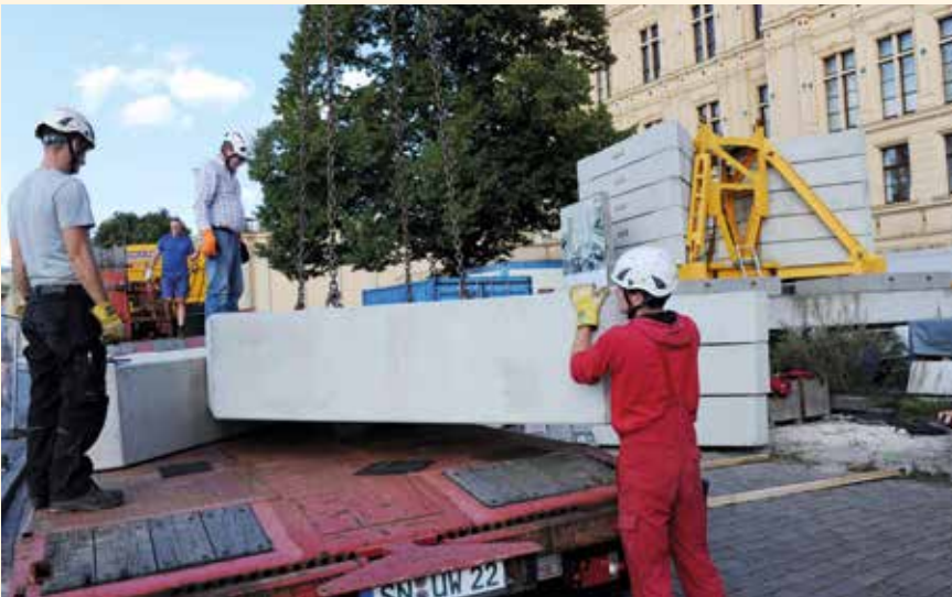
Tonnenschwere Gegengewichte haben dafür gesorgt, dass der Kran selbst bei Sturm sicher stand. Jetzt haben sie ihre Pflicht getan.
