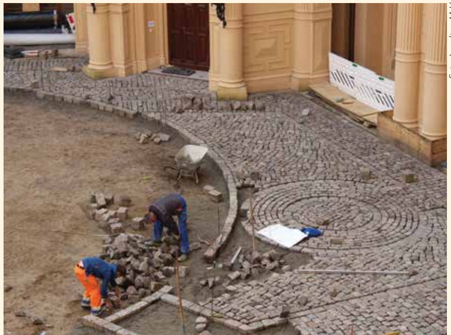
Der Schlosshof wird originalgetreu gepflastert.
