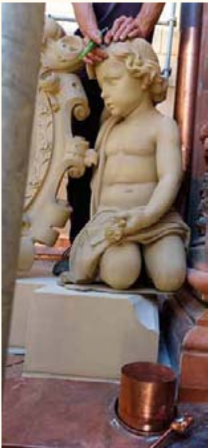
Das Aufstellen der Figuren auf dem Dach war Maßarbeit.
