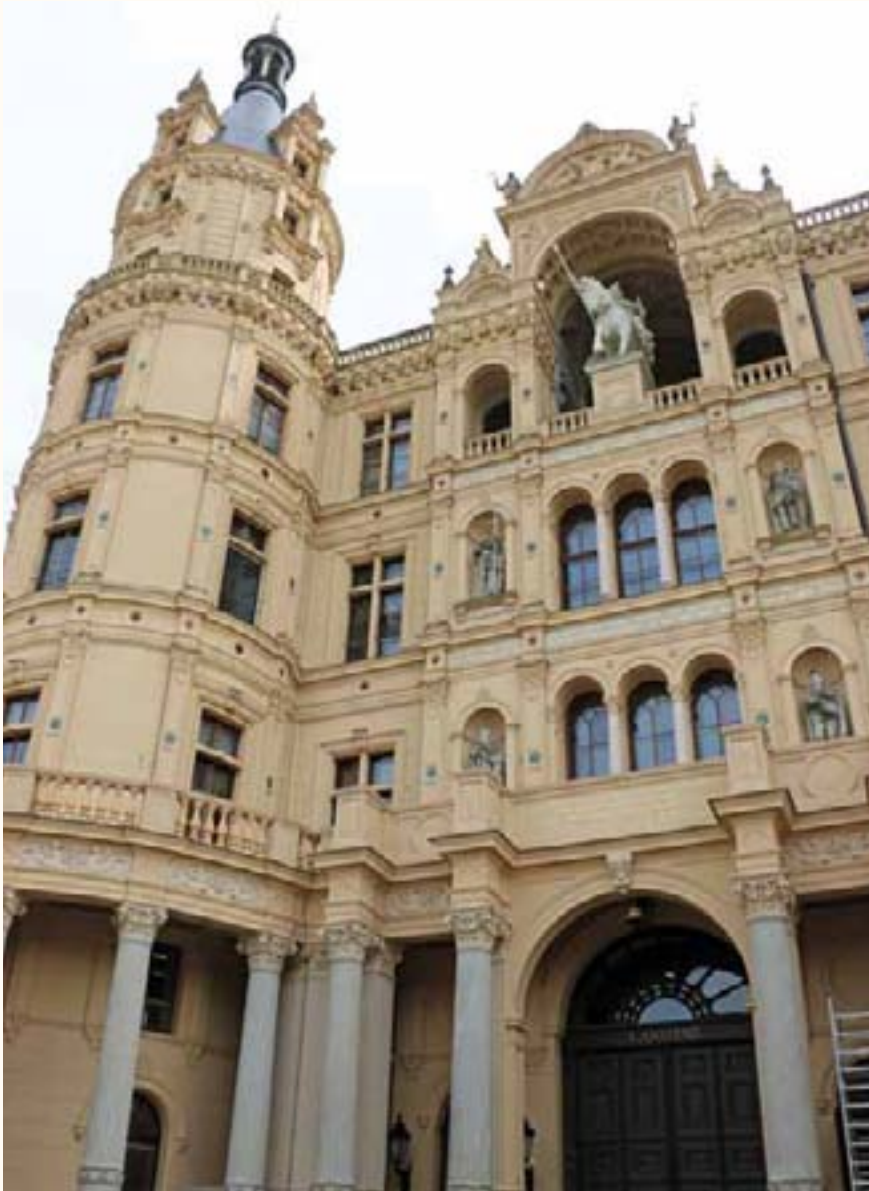
In diesem Jahr werden an der Stadtportalfassade Bauunterhaltsarbeiten ausgeführt.
