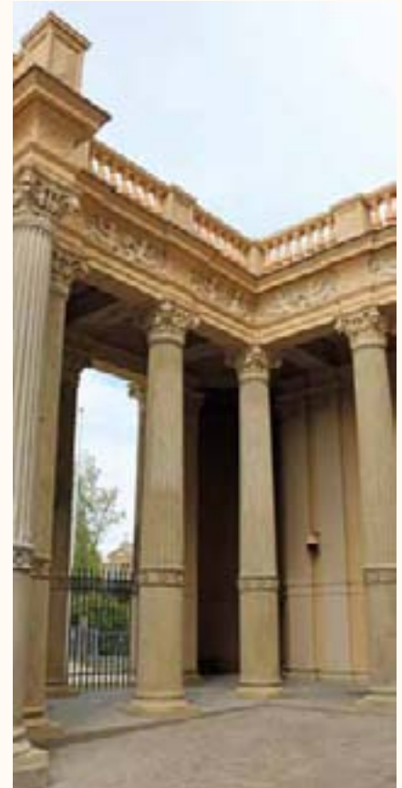
Ein Teil des fertig instandgesetzten Vorhofes.
