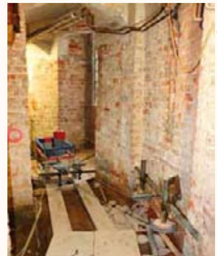
Zur Abdichtung wurden mittels einer Kettensäge horizontale Edelstahlbleche in die Pfeiler eingebracht.
