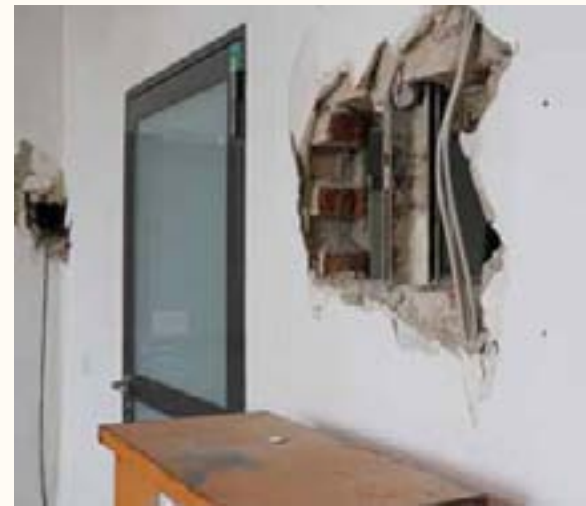
Bei einer Sondierungsöffnung im 6. Obergeschoss des Burgseeflügels wurden die Stahlabhänger freigelegt, über die die Geschossdecken mit der Dachkonstruktion verbunden sind.
