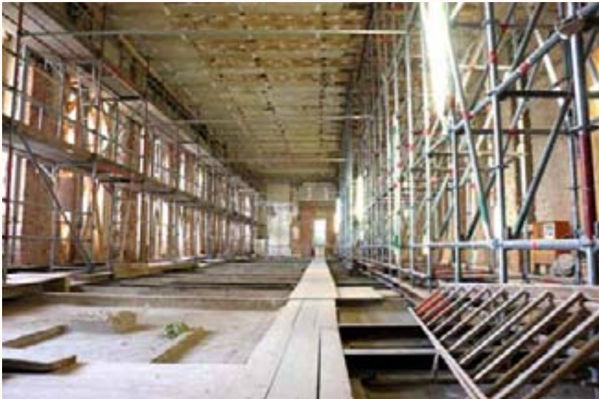
Der alte Plenarsaal im Burgseeflügel
