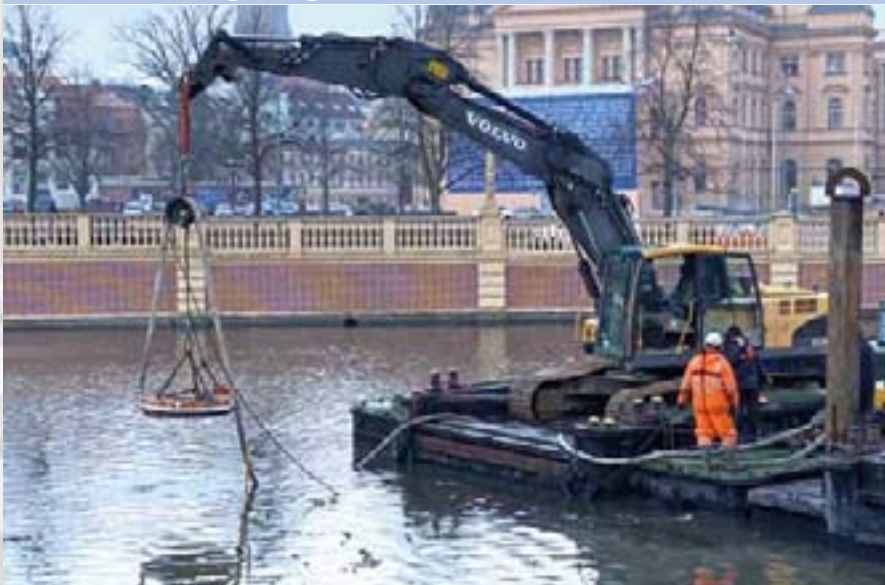
Mit einem Elektromagnet wurde unter Wasser der Boden um das Schweriner Schloss abgesucht.
