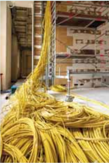
Datenleitungen für den neuen Konferenzbereich
