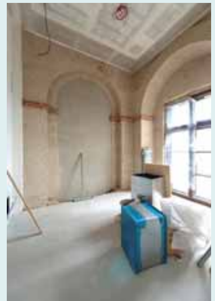
In den Büros im 4. Obergeschoss werden historische Elemente wie die Rundbögen erhalten und sichtbar bleiben.
